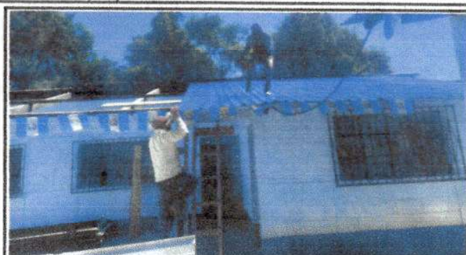
Foto 2: Colocación de la nueva lámina troquelada
