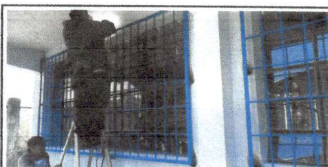
Foto 6: Colocación de estructura de metal de ventana
